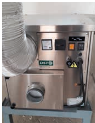
2. KÉP. PÁRATARTALOM MEGKÖTŐ BERENDEZÉS
